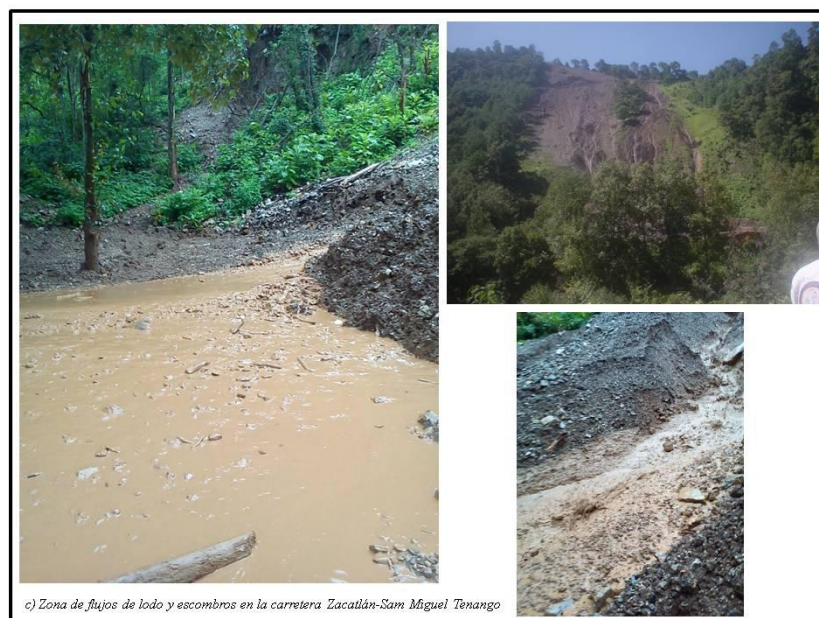
Figura V.22.- Imágenes de flujos de lodos en la carretera Zacatlán-S.M. Tenango
